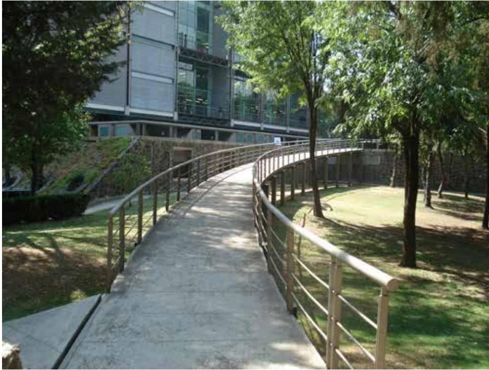
Foto 3. Rampa de acceso al edificio de la Torre de Ingeniería, Ciudad Universitaria
