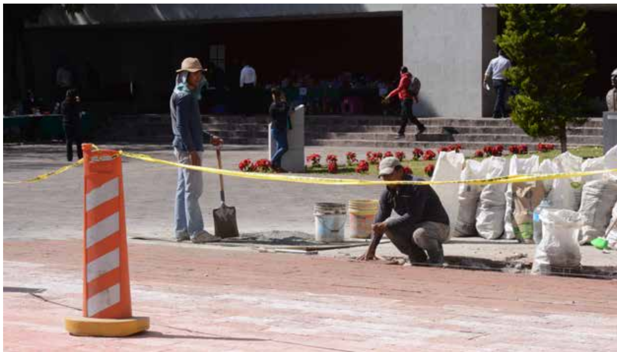
Entre las obras de mantenimiento del edificio sede, se llevó a cabo la reparación del adoquín de la plaza Gilberto Bosques.
