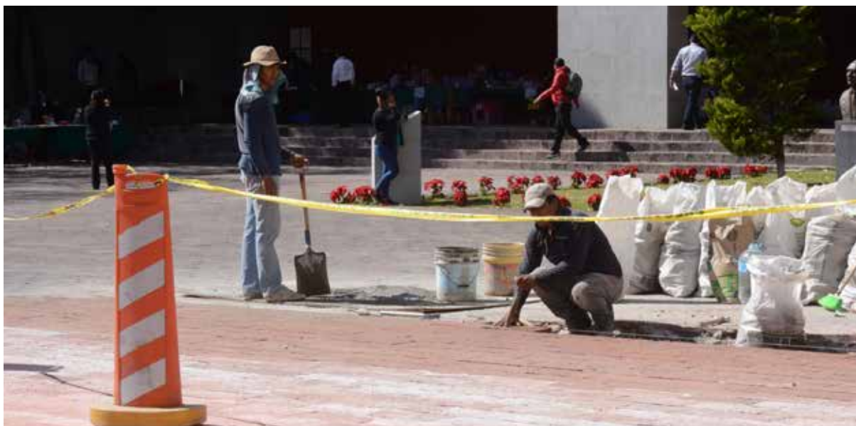
Entre las obras de mantenimiento del edificio sede, se llevó a cabo la reparación del adoquín de la plaza Gilberto Bosques.
